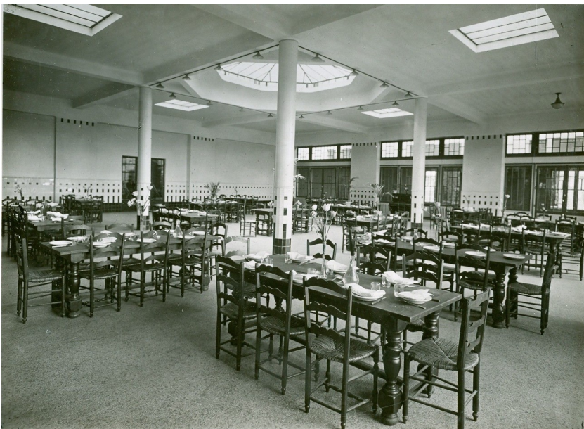
Salle à manger du foyer Jeanne d'Arc, vers 1930.
